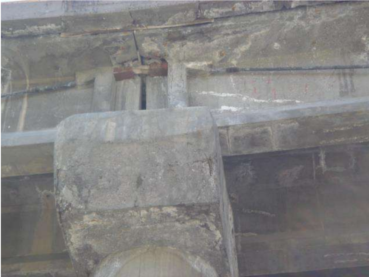
شکل ۵۸- نمونه ای از تقویت پل سعید آباد با استفاده از کابل‌های پس تنیده
