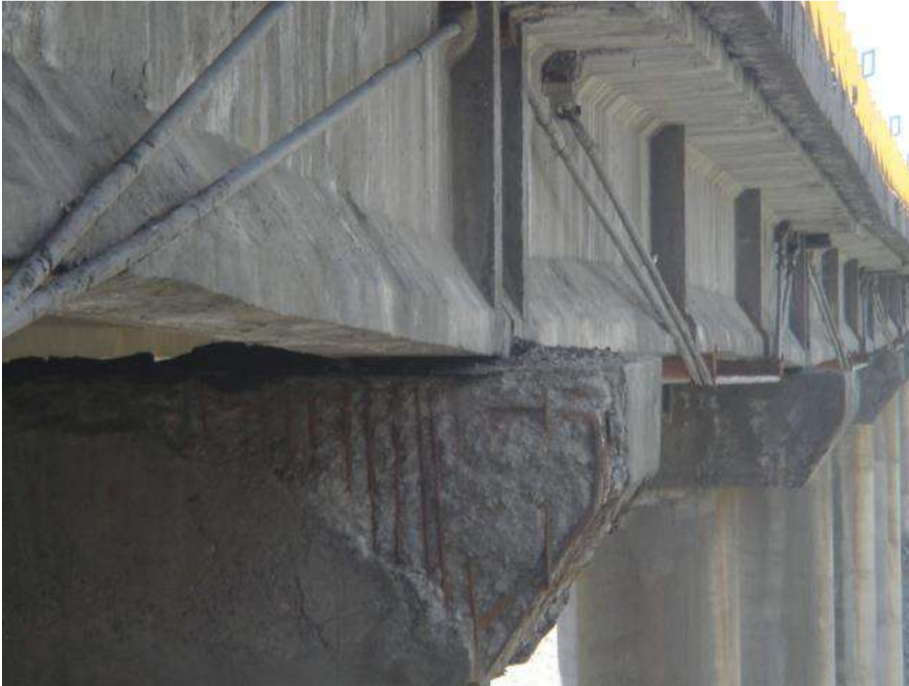
شکل ۵۷- نمونه ای از تقویت پل سعید آباد با استفاده از کابلهای پس تنیده
