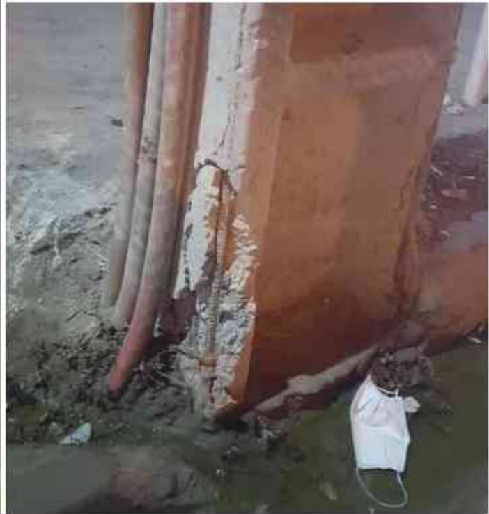
تصویر ۵۲: خوردگی آرماتور پای تیر برق در بافت فرسوده و محلات شهر بندرعباس
