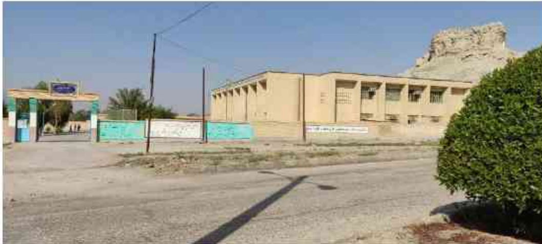
تصویر ۲۸ عدم آسیب دیدگی سازه و نمای مدرسه اسکلت بتنی در شهر فین
