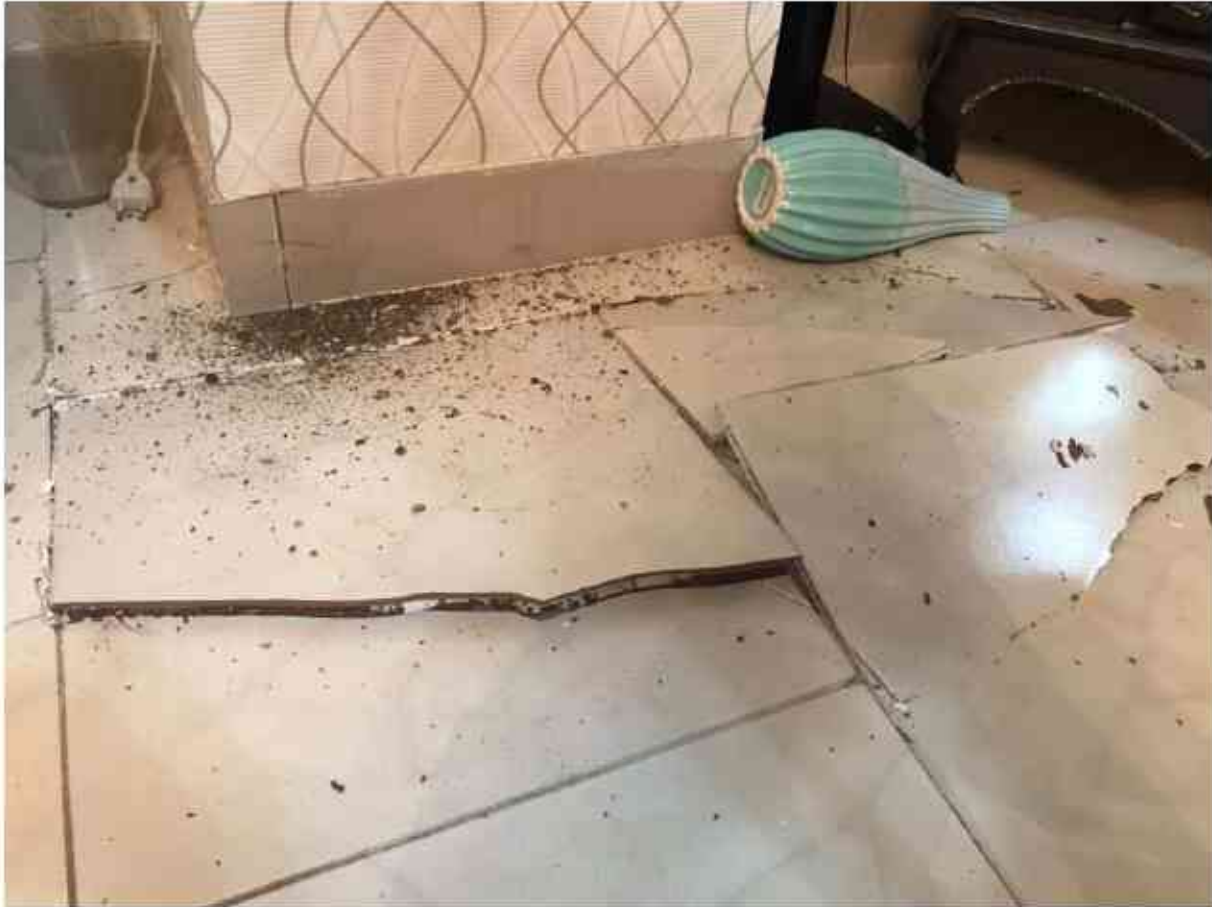
تصویر ۴۸ خرابی پای ستون در ساختمان بتنی ۶ طبقه در شهر بندرعباس
