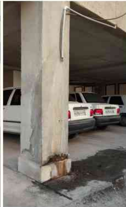
تصویر ۵۴ خوردگی ستون‌های بتنی و فرنداسیون سازه به دلیل هدایت اشتباه آب گوارهای گازی، لوله‌های آب باران و کف شور بالکن‌ها در پای ستون در مجتمع‌ها (بندرعباس)
