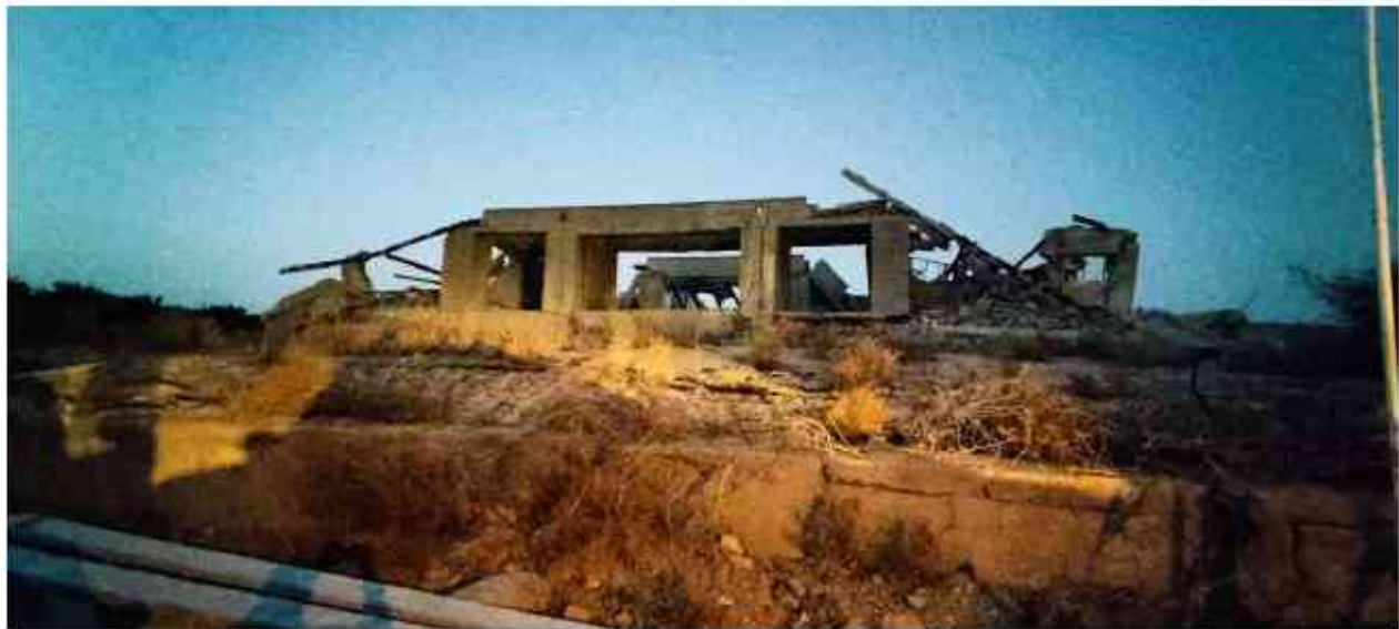
تصویر ۲۲ ریزش سقف و دیوار مدرسه ساخته شده بدون کلاف پس از زلزله ۱۳۵۶ در روستای گیشان غربی
