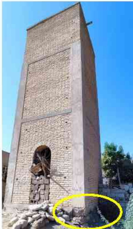
تصویر ۵۰ سازه بتنی منبع آب در روستای سرره
