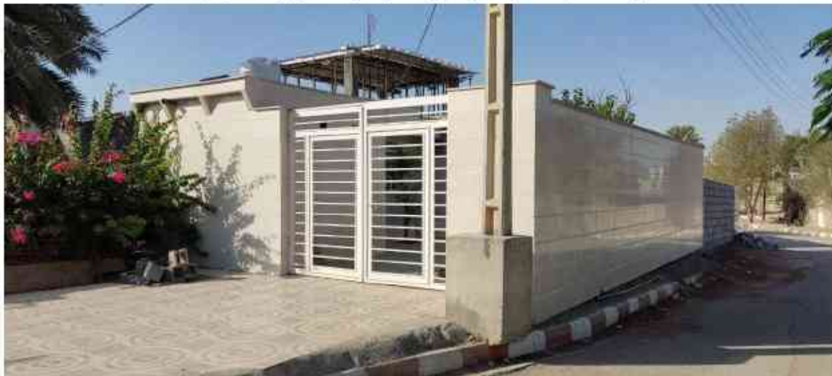
تصویر ۴۱ سالم ماندن سازه و نمای ساختمان دارای شیار در روستای سرزه
