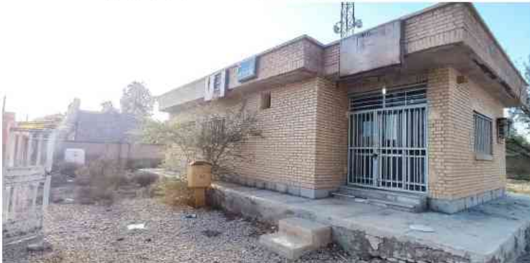
تصویر ۲۹ پایداری ساختمان مخازرات در روستای سیاهو (دستگاه شتاب‌نگاری مرکز تحقیقات در این مکان قرار دارد)
