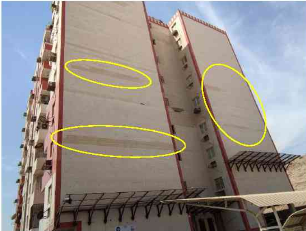
تصویر ۶۱ ایجاد محافظ به‌منظور جلوگیری از سقوط نما بر روی ساکنین مجتمع در بندرعباس
