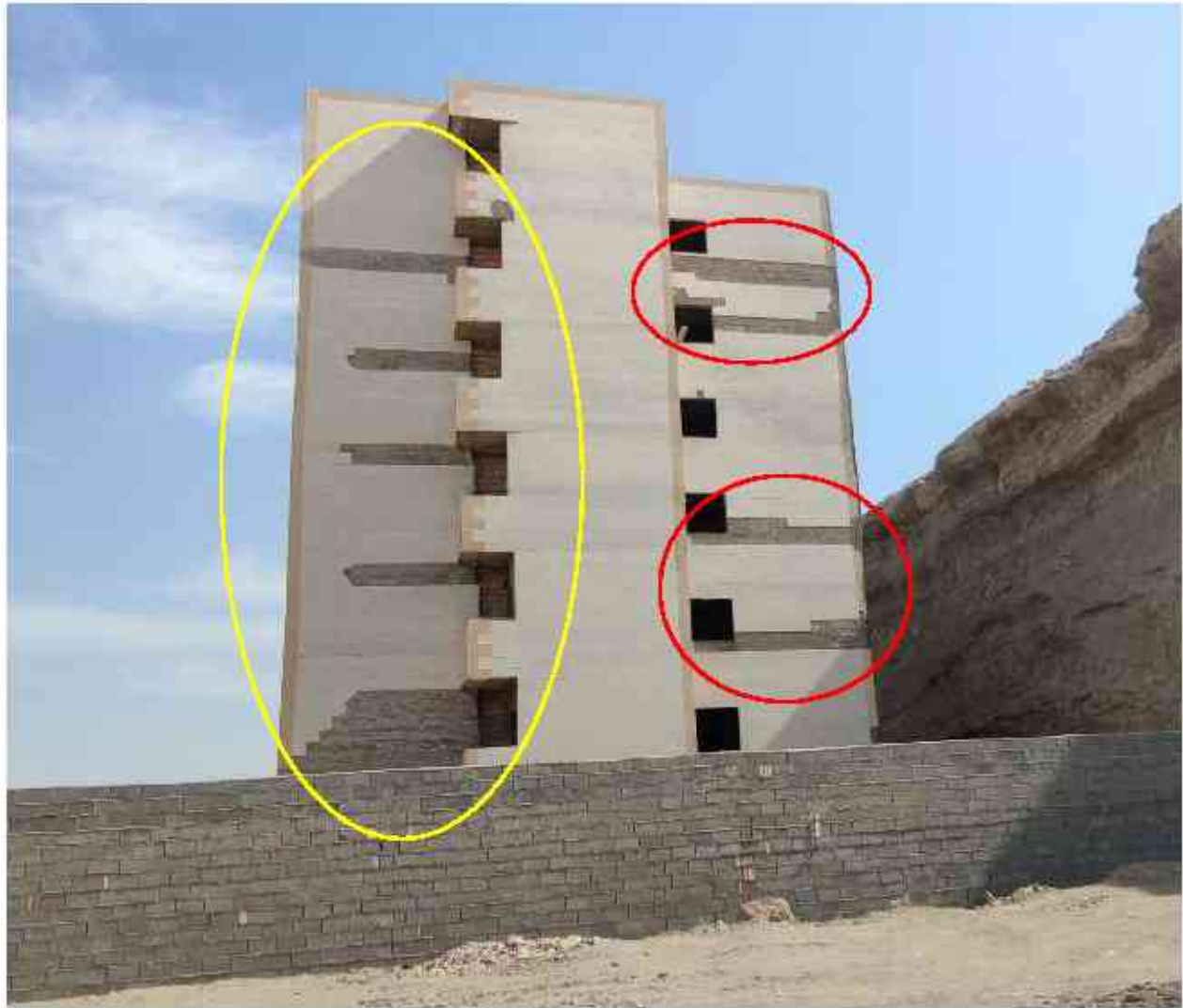
تصویر ۶۴ دیدش نما در ساختمان اسکلت بتنی قبل از بهره‌برداری در بندرعباس
