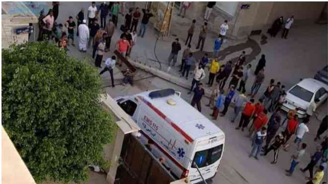
تصویر ۱۰۸ سقوط تیر برق به دلیل خوردگی بتن و کج بودن و قوت یک نفر در شهر بندرعباس
