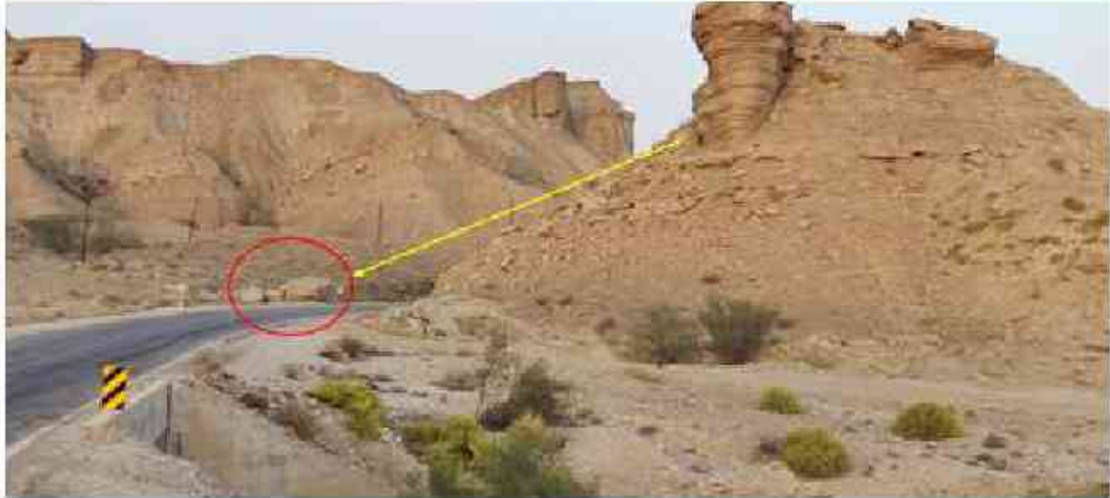
تصویر ۱-۲ ریزش کوه و پتانسیل بالقوه ریزش مجدد در مجاورت جاده روستای سیاهو
