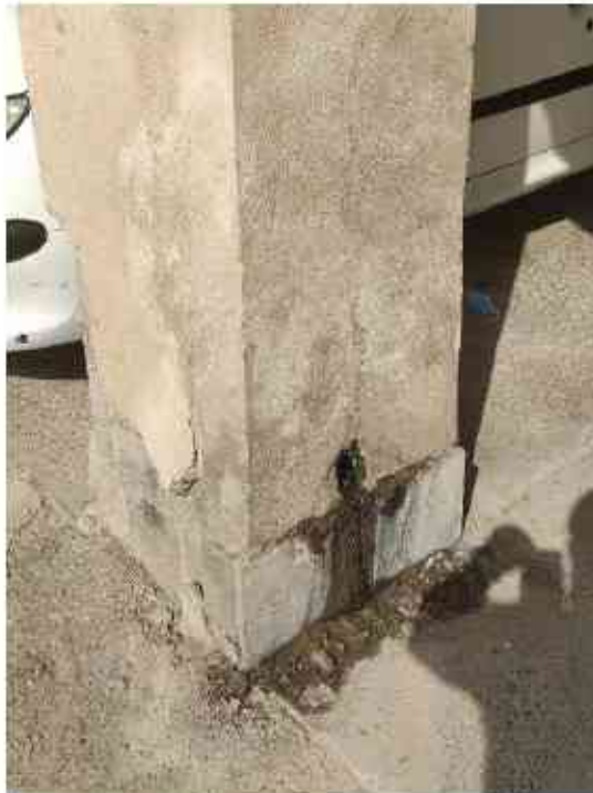
تصویر ۵۴ خوردگی ستون‌های بتنی و فرنداسیون سازه به دلیل هدایت اشتباه آب گوارهای گازی، لوله‌های آب باران و کف شور بالکن‌ها در پای ستون در مجتمع‌ها (بندرعباس)
