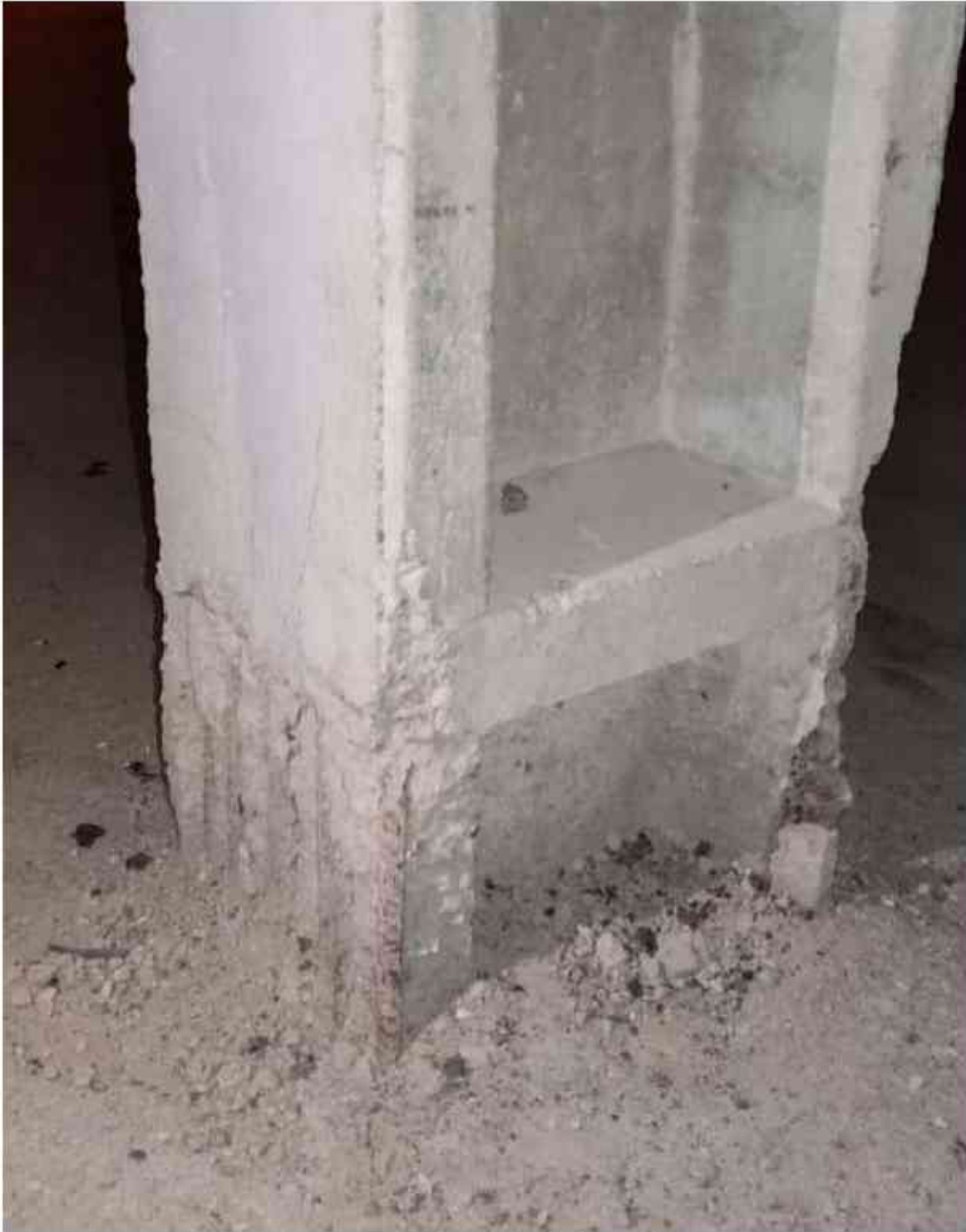
تصویر ۵۱ خوردگی آرماتور پای تیر برق در شهر بندرعباس
