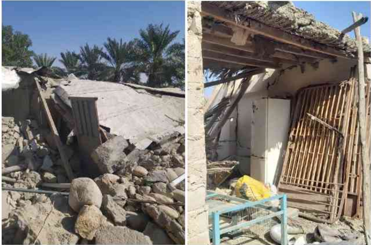
تصویر ۲۱ ریزش دیوار و سقف خانه‌های خشتی و گلی در روستای مژرا
