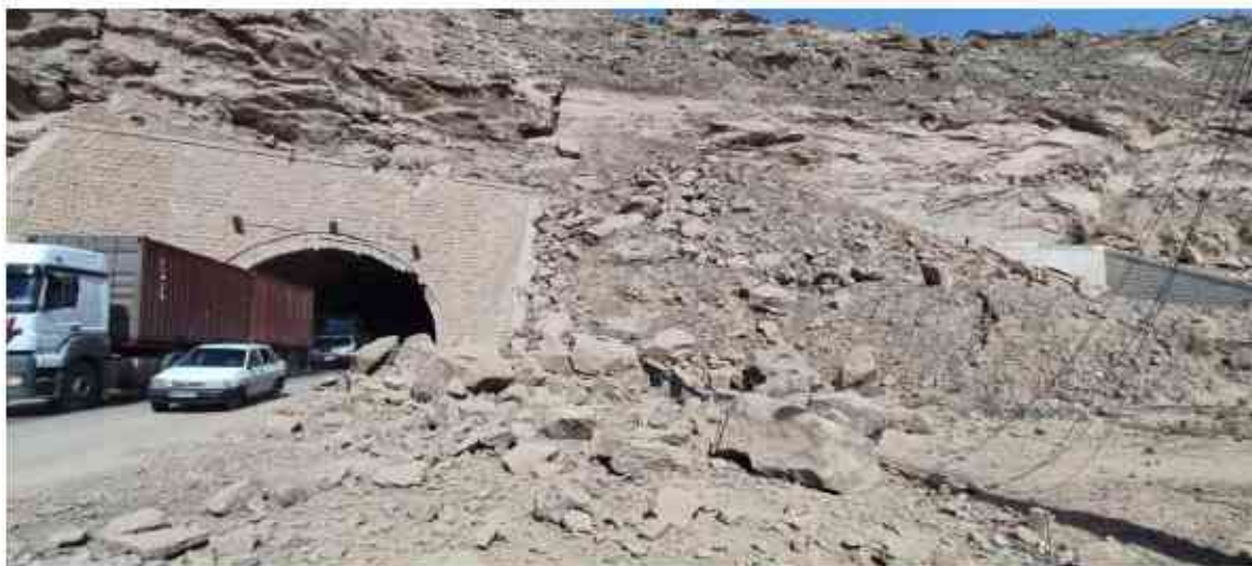
تصویر ۱-۳ ریزش لایه‌های ناپایدار و مسدود کردن دهانه خروجی تونل شهید میرزایی و خرابی شبکه برق
