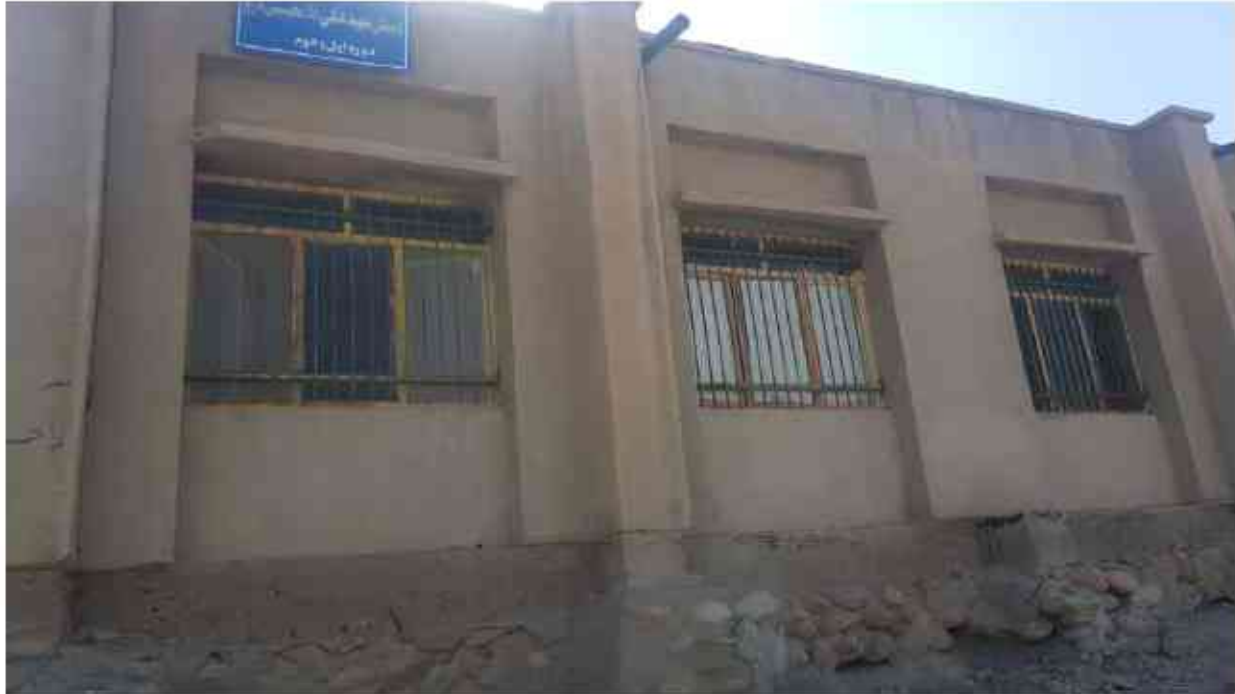
تصویر ۴۰ عدم ایجاد ترک خوردگی و خسارت در دیستان روستای ذرتو
