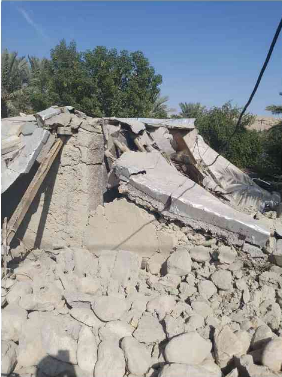
تصویر ۲۵ ریزش سقف یا تیرکهای چوبی و دیوارهای سنگی در روستای مزرا
