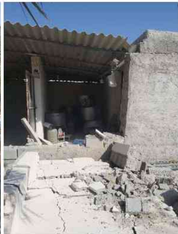
تصویر ۲۷ ریزش دیوار خانه‌های بلوک سیمانی در روستای مزرا
