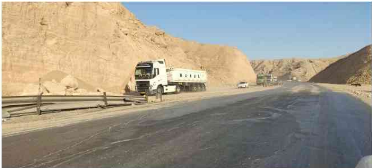
تصویر ۱-۰ مسدود شدن یک باند جاده بندرعباس - سیرجان بر اثر ریزش قطعات سنگی از شیب مجاور در نزدیکی تونل شهید میرزایی
