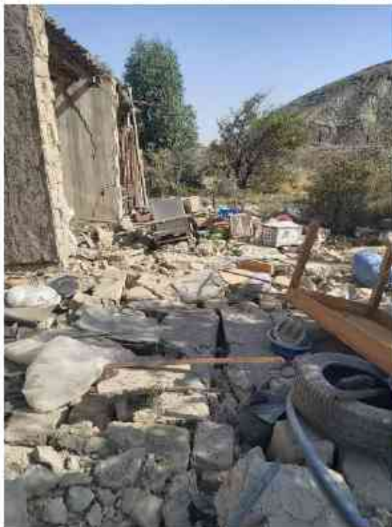
تصویر ۲۷ ریزش دیوار خانه‌های بلوک سیمانی در روستای مزرا
