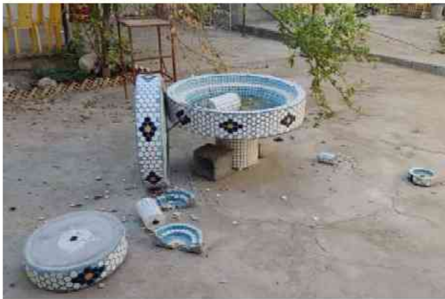
تصویر ۷۸ حوض مطابق تخریب شده در حیاط روستای سرزه
