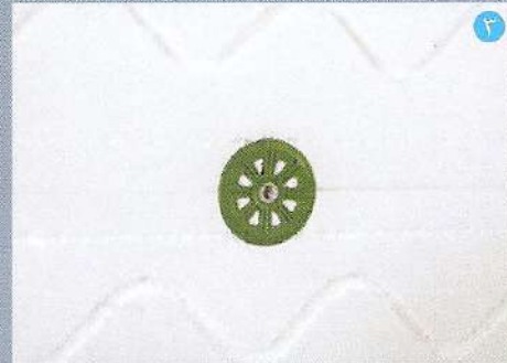
نصب بست های Termofix
