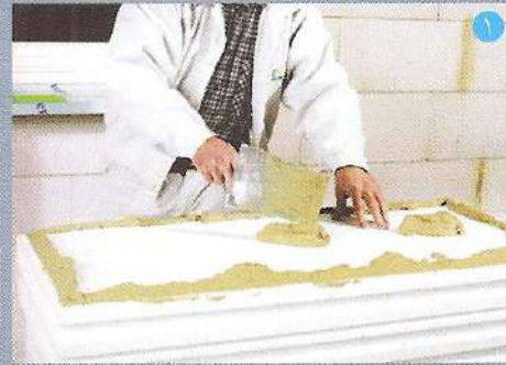
نشاندن چاهه های SM700 بر روی قطعات عایق
