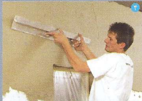
اجرای اندود SM700
