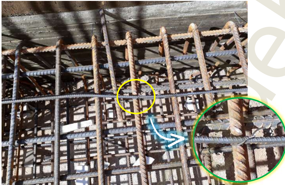
میلگرد همبندی با سیم آرماتوربندی به میلگرد سازه بسته شده تا جابجا نشود
