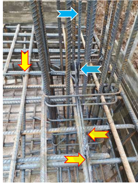
جوش دادن میلگرد همبندی در فونداسیون توسط قطعه L شکل به میلگرد همبندی ستون
