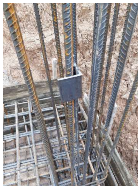
میلگرد همبندی که تا بخشی از ستون ادامه داشته و قطعه اتصال به آن جوش داده شده
