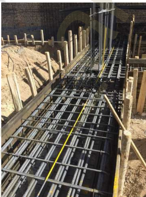
میلگرد همبندی رنگ آمیزی شده برای متمایز شدن آن؛ گرچه رنگ آمیزی روش درستی نیست
