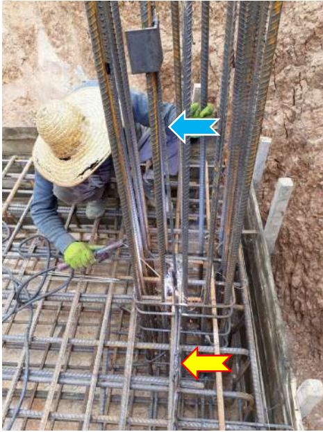
جوش دادن میلگرد همبندی در فونداسیون توسط قطعه L شکل به میلگرد همبندی ستون
