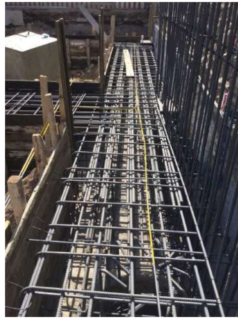
میلگرد همبندی رنگ آمیزی شده برای متمایز شدن آن؛ گرچه رنگ آمیزی روش درستی نیست
