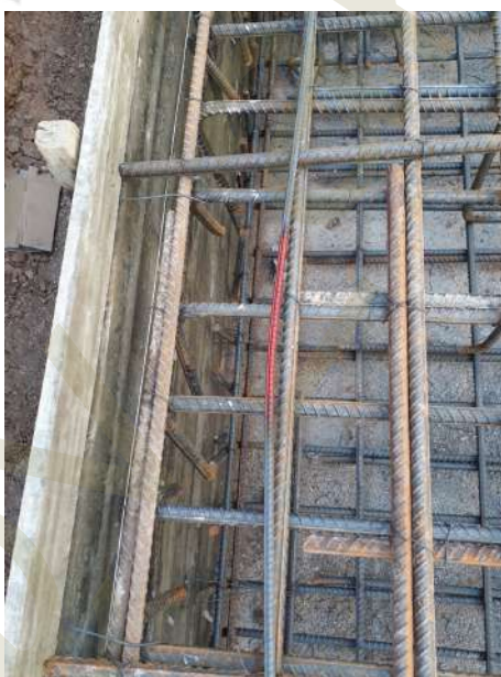
جهت تمایز، میلگرد همبندی بصورت موردی لکه گذاری شده است
