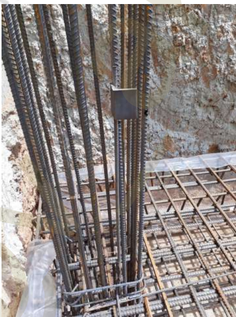
میلگرد همبندی که تا بخشی از ستون ادامه داشته و قطعه اتصال به آن جوش داده شده
