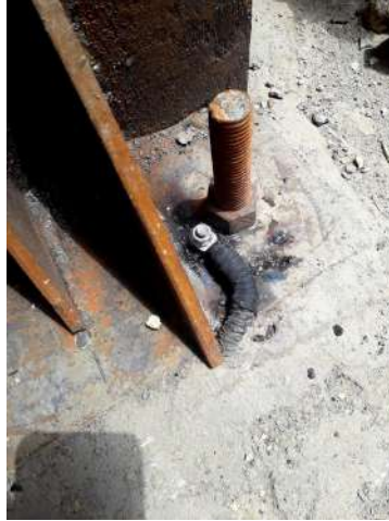
جوش پیچ به صفحه ستون و بستن کابلشو
