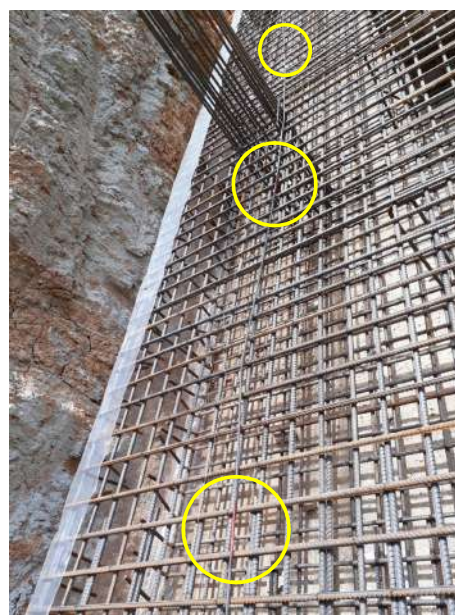
جهت تمایز، میلگرد همبندی بصورت موردی لکه گذاری شده است
